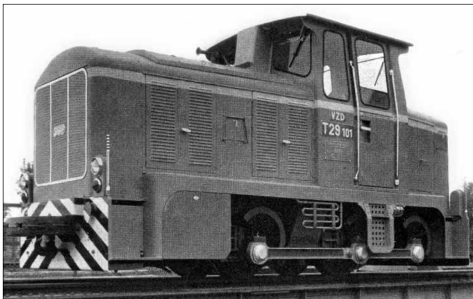
Snímek lokomotivy T 29.101 pořízený před expedicí z továrny SGP v roce 1960. Na obrázku je dobře patrný spojnicový pohon obou dvojkolí od jalového hřídele.
